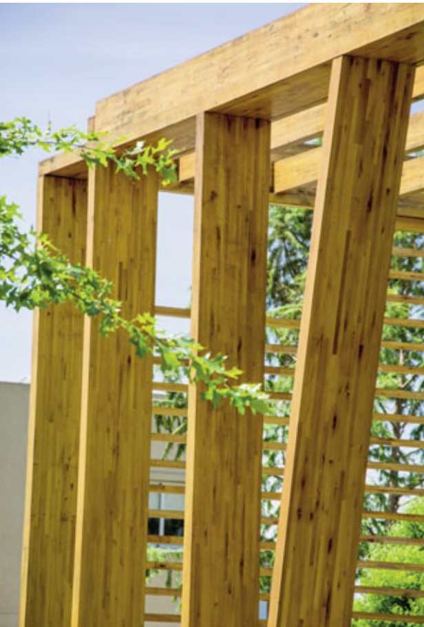
En la obra se desarrolló un uso mixto de los sistemas de bastidores, y poste y viga.
