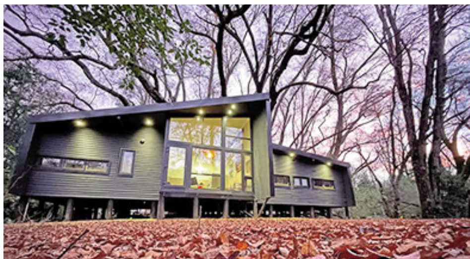
La edificación se emplaza en un claro y sobre una pequeña pendiente con la finalidad de no eliminar árboles y mejorar las vistas al bosque desde el interior de la obra. Imagen otoñal.
