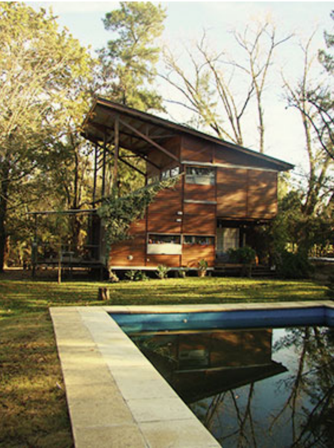
La obra se construyó entre 2001 y 2002. Los arquitectos recurrieron a mano de obra calificada de techos.
