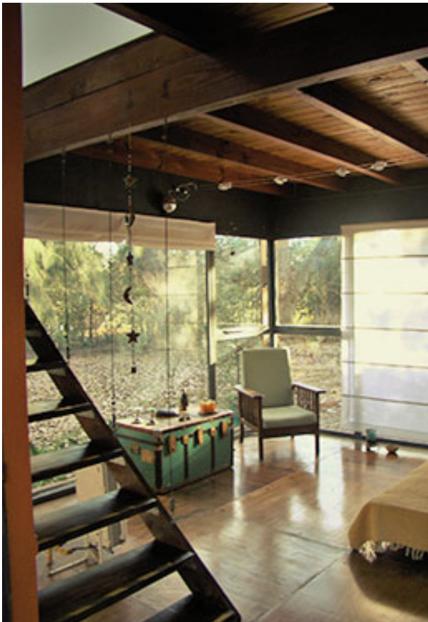
Los pisos son de multilaminado fenólico de eucalipto de 18 milímetros de espesor.
