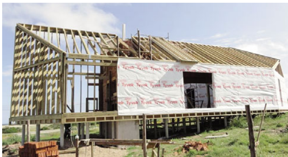
El bastidor, junto con las placas de rigidización, forman la estructura. Luego en los espacios entre parantes se coloca la capa de aislación térmica. Por fuera la capa hidrófuga.
