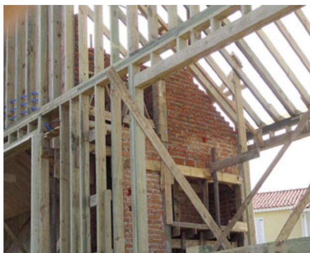
Cerrando el sistema de bastidores y como elemento de rigidización (sheating) se emplearon placas de multilaminado fenólico.
