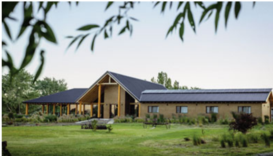
TAO construye el Lodge Chochoy Mallín, un refugio contemporáneo en el norte de Neuquén.
