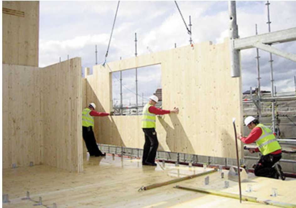
La ligereza de la madera permite un montaje más rápido, reduciendo así los tiempos de construcción.
