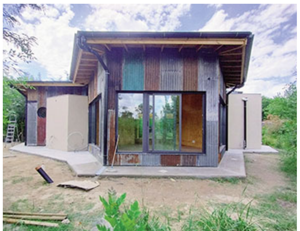
Las fachadas son todas en maderas recicladas provenientes de demoliciones y la chapa utilizada también fue reciclada.
