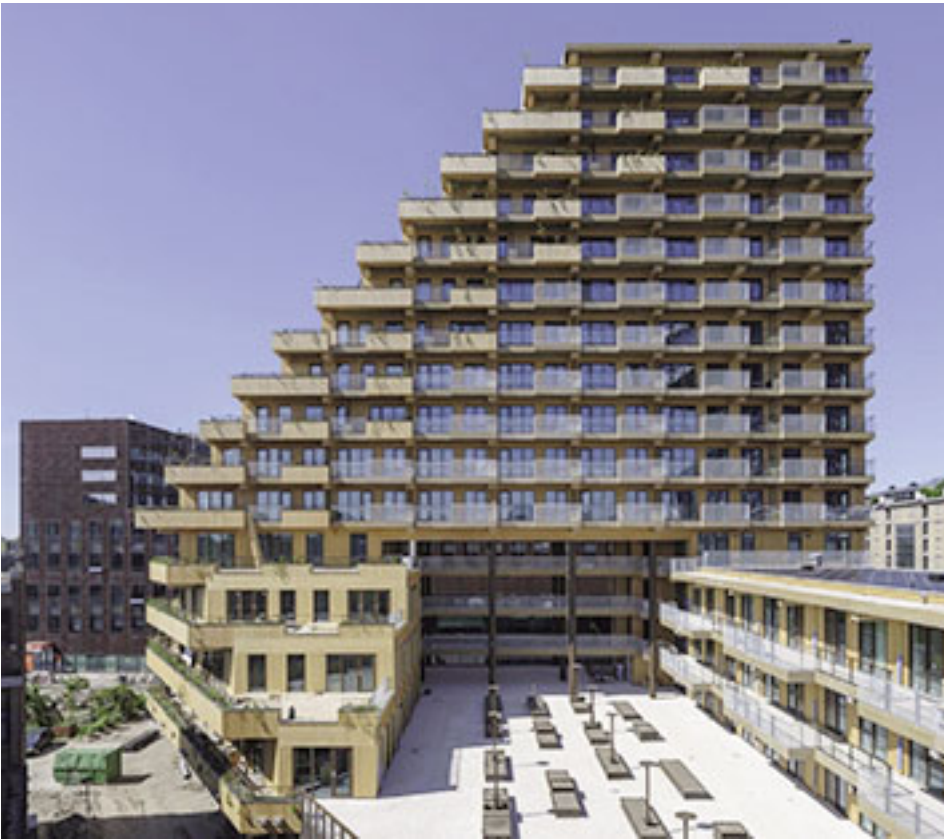
La estructura está realizada en más de un 90% con madera: 3.800 m 3 entre suelos y paredes de CLT, y columnas y vigas de madera laminada encolada.
