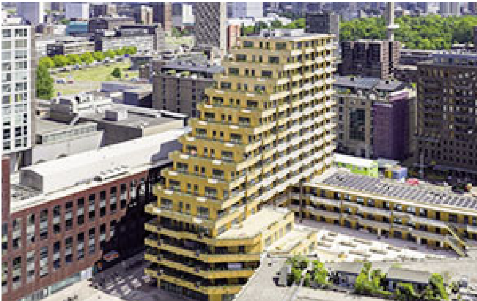
La estructura está realizada en más de un 90% con madera: 3.800 m 3 entre suelos y paredes de CLT, y columnas y vigas de madera laminada encolada.
