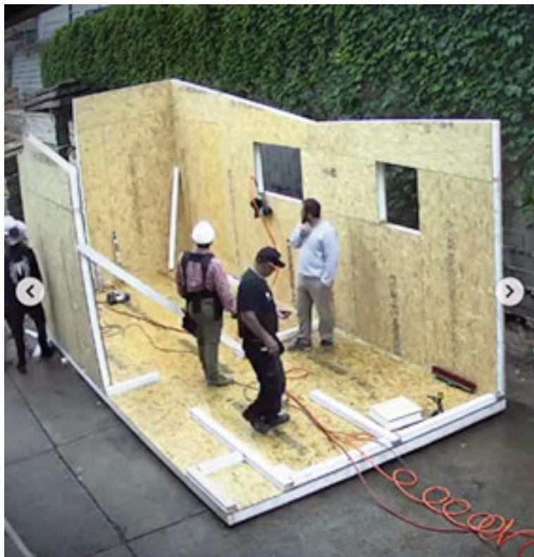
Comienzo de la construcción del módulo Landscape. "Durante seis días, el equipo de @palafito_delta, junto a constructores amigos, levantó el módulo Landscape de @apeo.arquitectura en pleno corazón de Maderera Newton, utilizando el KIT de Paneles SIP-TAO", señalaron desde TAO.
