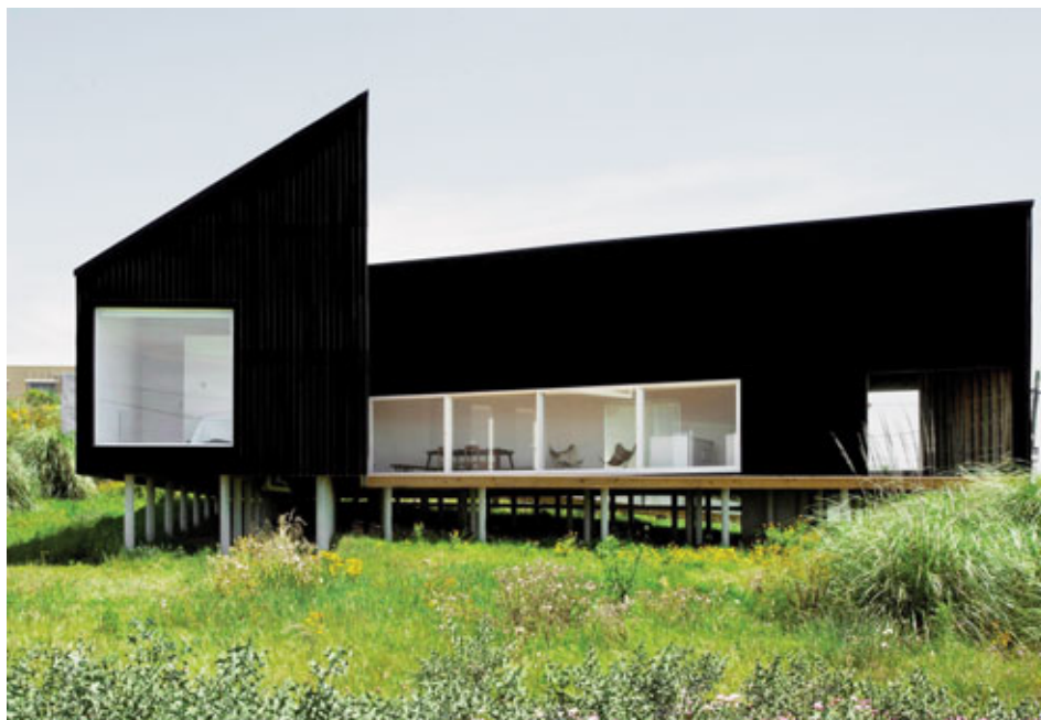
“La elección de madera proveniente de forestaciones locales como material básico de construcción responde a la voluntad de reducir costos y tiempos a través de la prefabricación modulara, así como de utilizar materiales de origen sustentable”, le dijo el arquitecto Diego Arraigada a Todo Madera.
