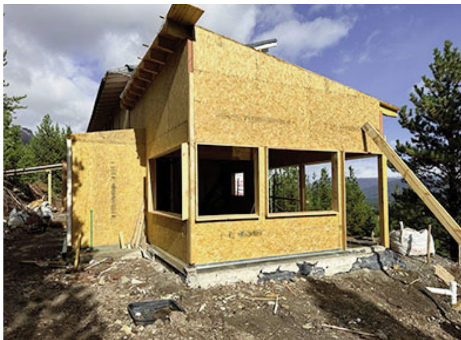
Vista de la construcción sin el revestimiento.
