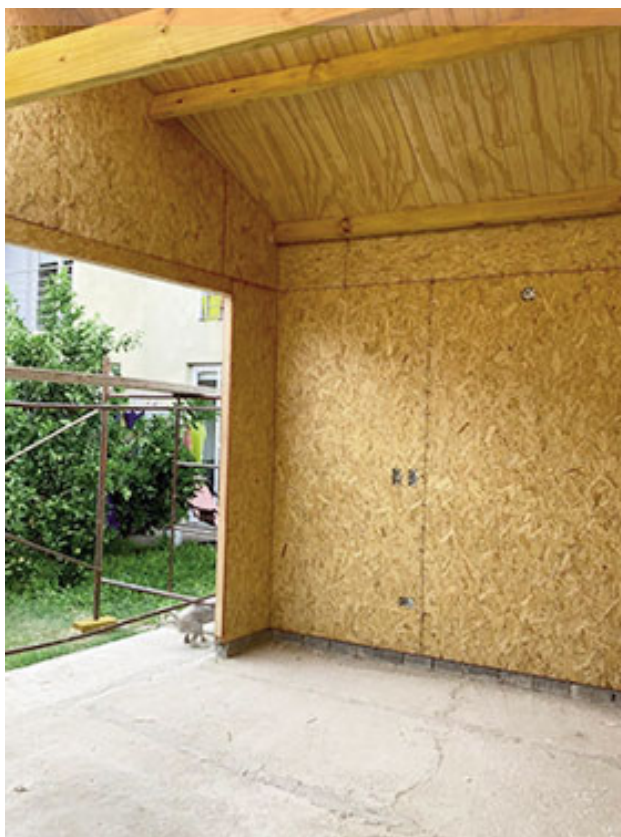
Un panel SIP soporta 15 toneladas en compresión.
