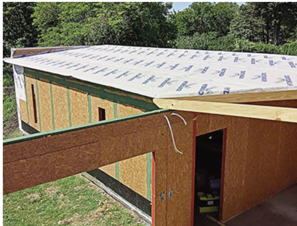
Colocación de aislante.
