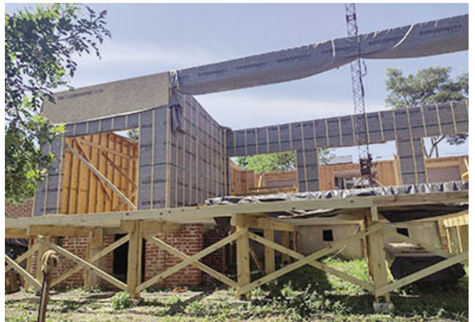
Colocación de aislantes.
