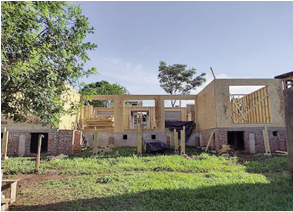
Nivelación de terrenos con muros perimetrales.
