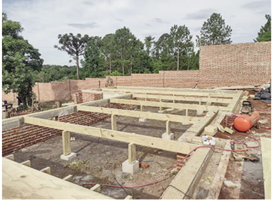
Montaje de las bases.
