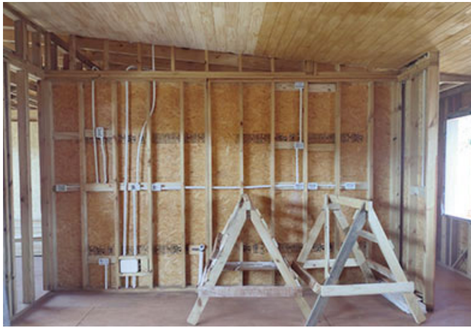
Vista interior de un bastidor arriostrado con placas de OSB.
