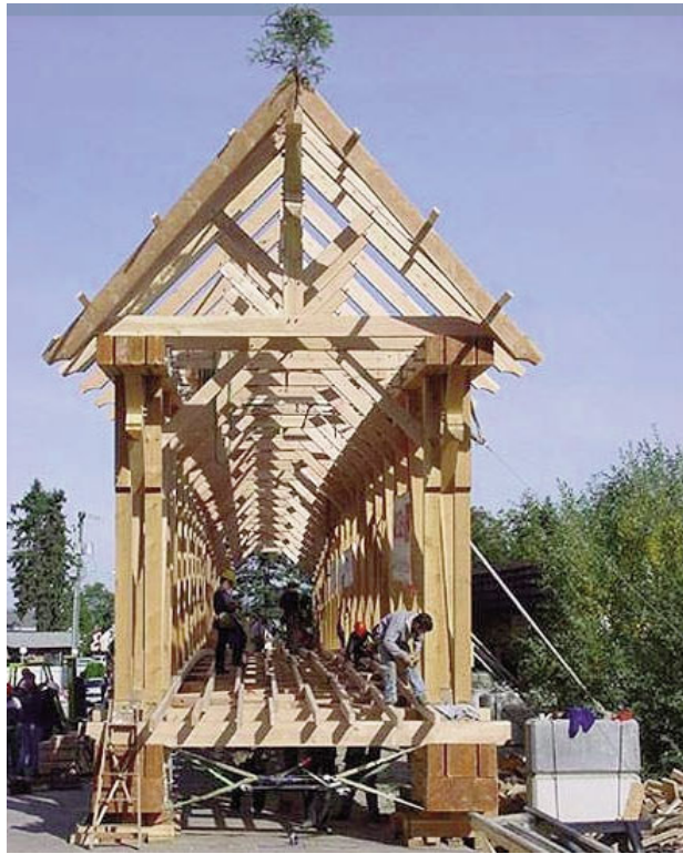
La cubierta también posee cruces para la rigidización de la estructura.
