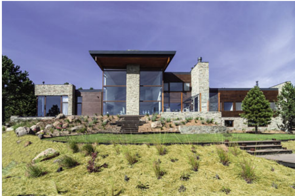
SIPANEL ha concretado varias obras de "casas pasivas".
