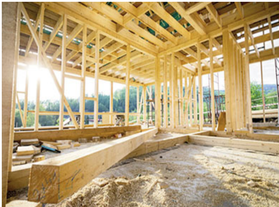
Sistema constructivo con bastidores de madera.
