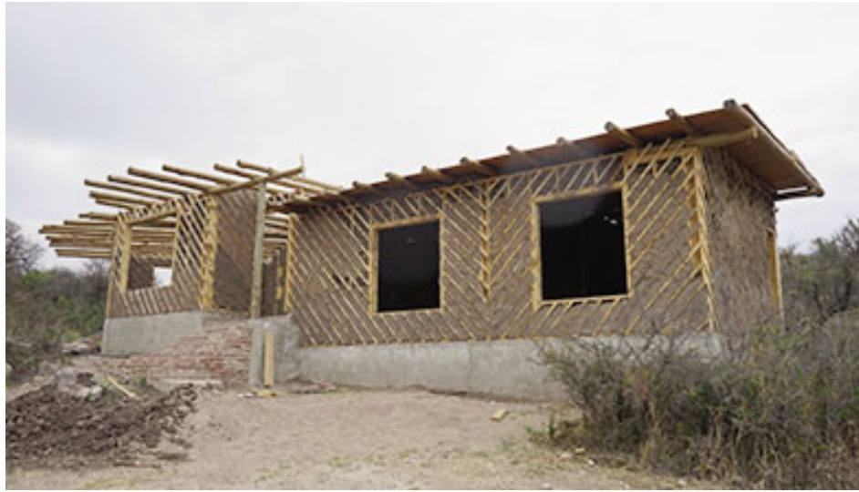
Pared de "quincha" con su relleno avanzado.
