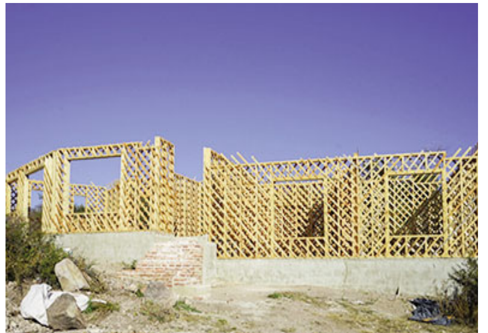
Entramado en madera de una futura pared a construir con la técnica de "quincha".
