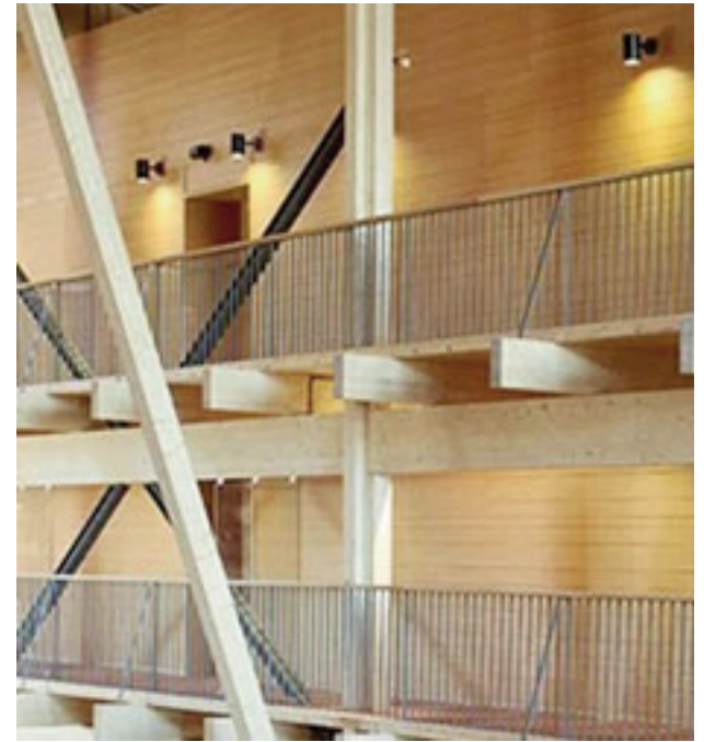
Edificios de madera sostenidos en vigas de MLE.
