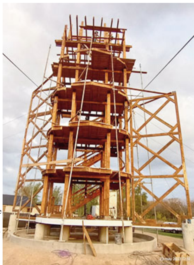
La obra se construyó en cuatro meses.
