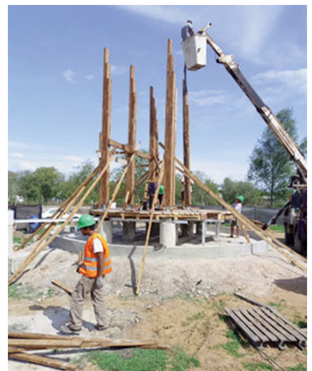
Montaje inicial de los tirantes.
