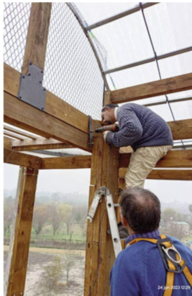
Montaje final del coronamiento.
