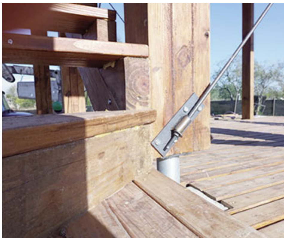
Detalle de la escalera y de un tensor.
