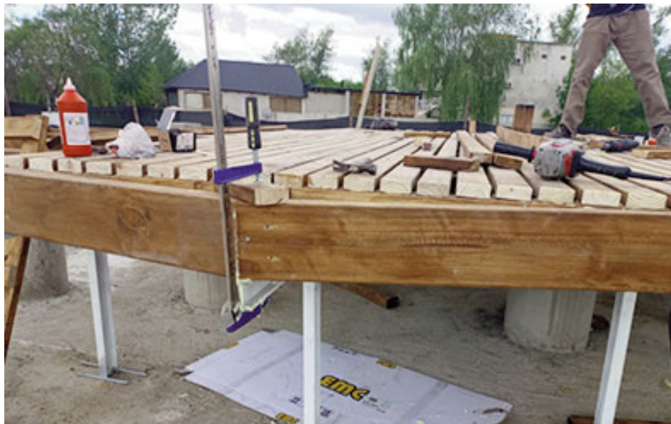
"Pasamos de una escuadría rectangular a una forma redonda, que en madera es algo difícil de llevar", explicó el constructor. Utilizaron Fanatite como adhesivo.
