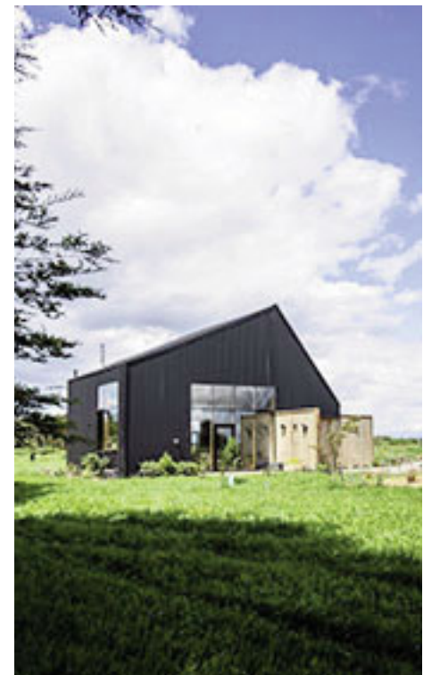
El sistema estructural de Casa Cumbre es una vivienda en estructura mixta de acero y tabiquería tradicional de madera.
