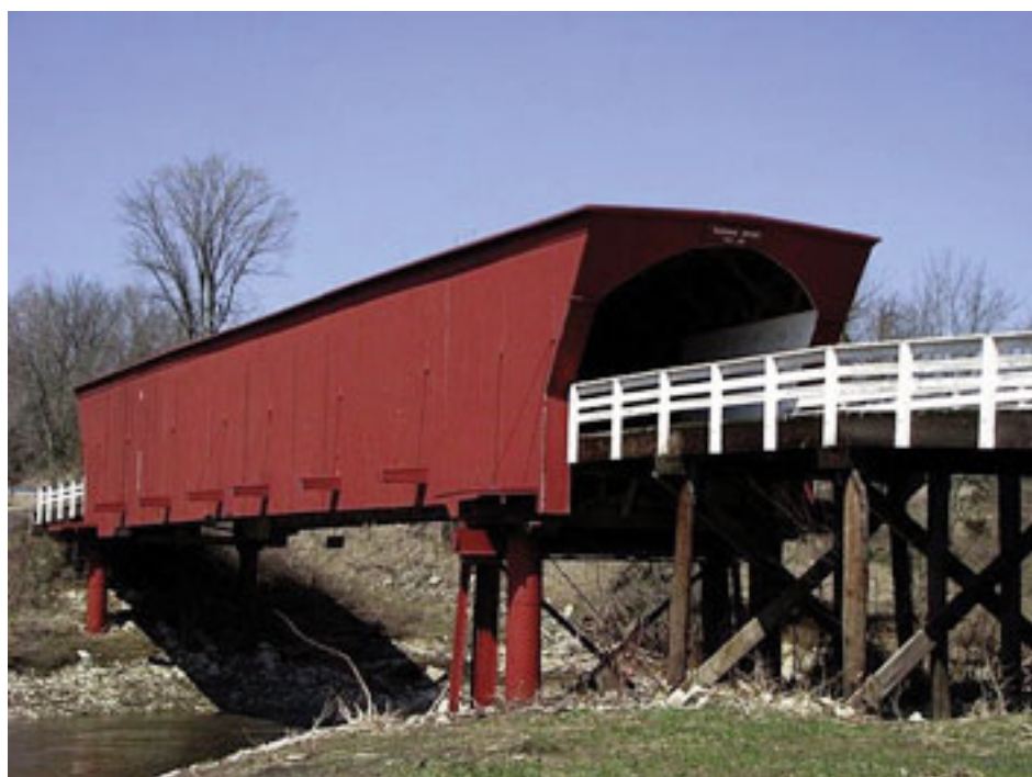
Los Puentes del Condado de Madison eran originalmente 19, de los cuales ahora sólo seis subsisten. Todos fueron construidos entre 1870-1884 y fueron techados para proteger las vigas del suelo, ya que era muy costoso reemplazarlas.
