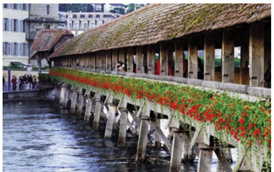
Puente de la capilla, en Lucerna, Suiza. Data del siglo XIV, tiene 204 metros de largo y conecta al Casco Antiguo con la Ciudad Nueva, sobre el río Reuss.
