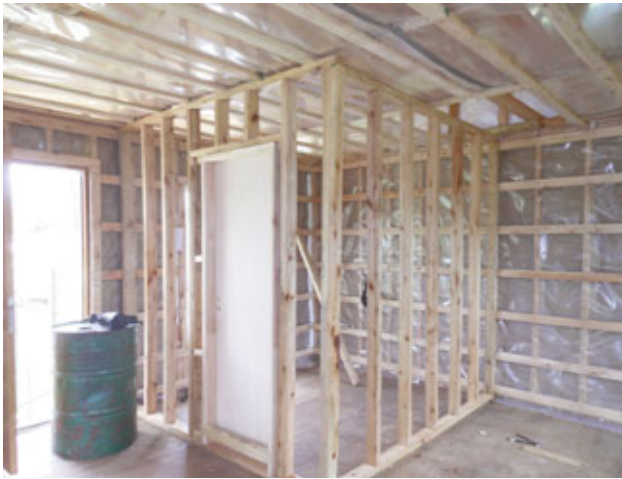
Después de colocar las ventanas se subdivide la casa. Tiene la ventaja de que en un futuro puedo mover las subdivisiones, porque los paneles no son portantes.
