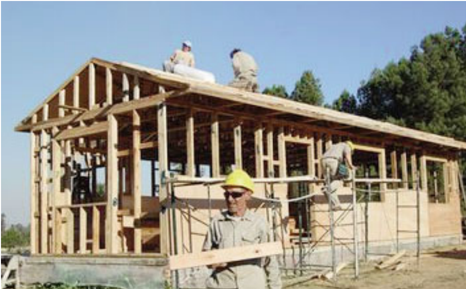
En el Día 2 de trabajo ya se termina con la casa techada. "Tenemos que cerrar la carcasa. Y una vez dado este paso, el propietario ya se puede meter y empezar a vivir", dijo el desertante.
