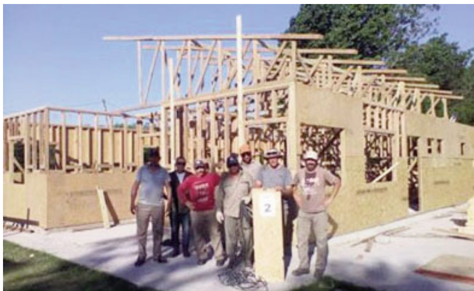
Fin del Día 2. Se trata de la primera Agencia de Extensión autoconstruida con personal de campo, con prefabricación de las piezas parte en madera de eucalipto grandis clasificada y calibrada para uso estructural, proveniente de Concordia.
