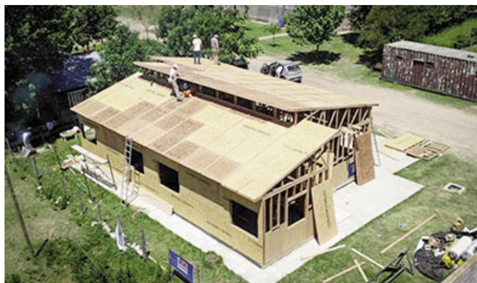
Vista desde un dron, tras el cuarto día de trabajo. "Ya desde el día 5 se pudo comenzar a techar y continuar con las instalaciones y acabados internos y externos", dijo Martín Sánchez Acosta.
