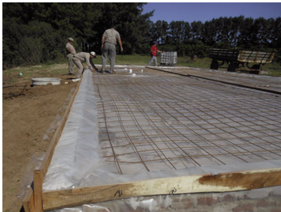
La zapata lleva polietileno de aislación sobre la arena y arriba de ella va la carpeta con una malla encima.
