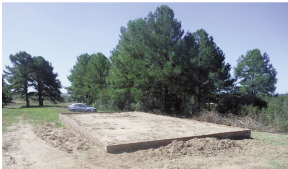
La fundación sobre la que se edifica la casa es lo que se conoce como "zapata corrida".
