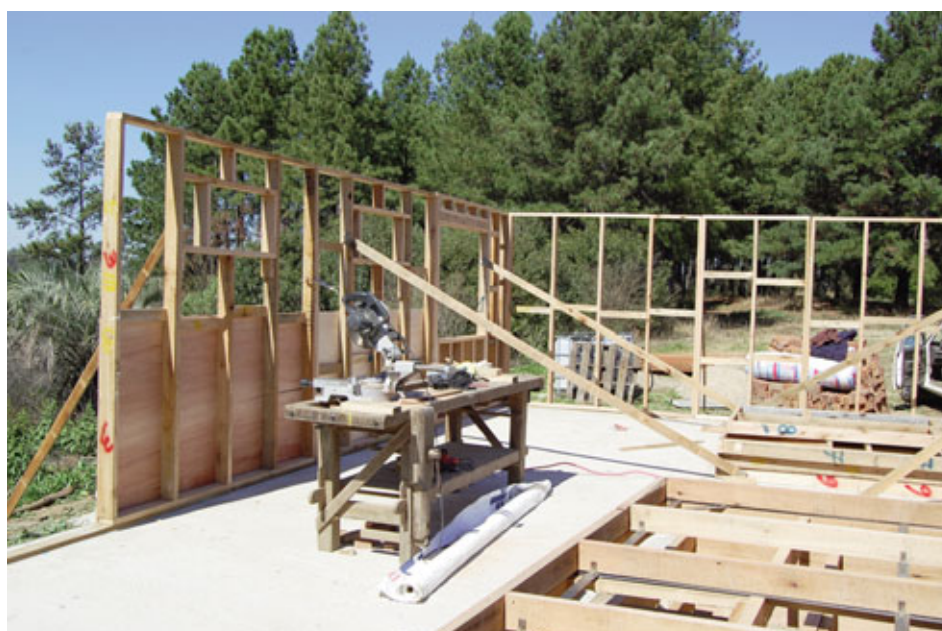
Se usó madera de eucalipto grandis de Entre Ríos en esta construcción de 2013.
