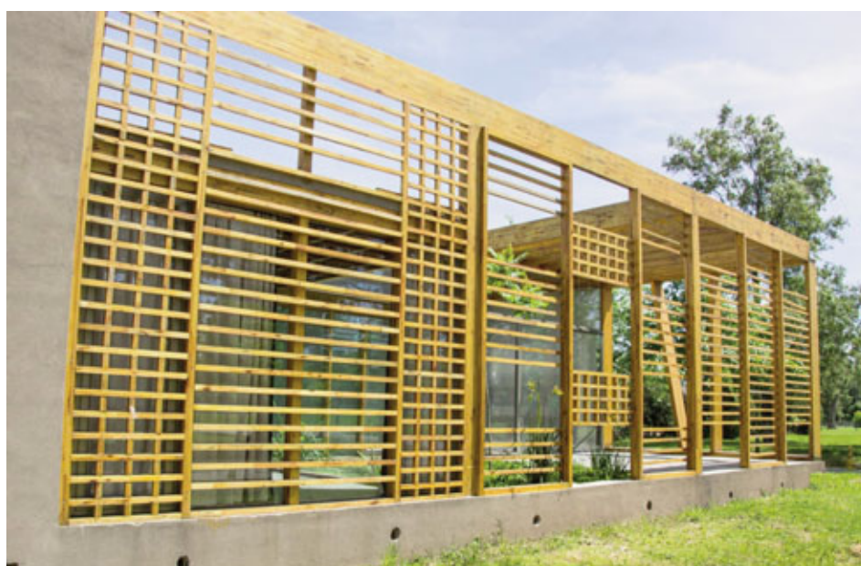
El 80 por ciento de la obra se ejecutó con madera certificada de bosque implantado.
