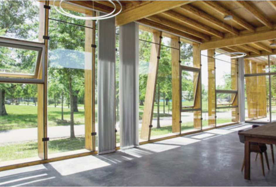
La casa cuenta en casi todas las resoluciones con aberturas fijas, que se realizaron con “un routeo en la misma estructura de madera”.
