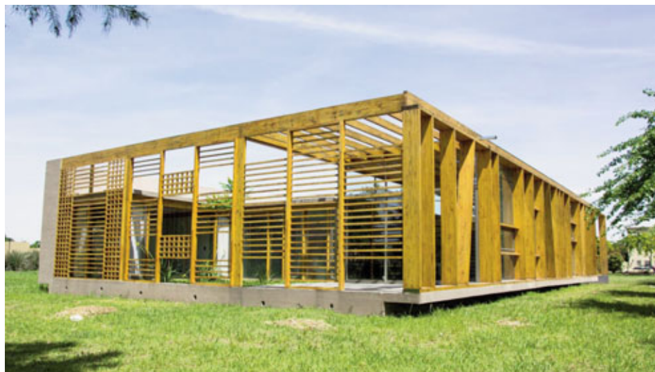
La estructura de la vivienda en su totalidad de viga laminada encolada de eucalipto.
