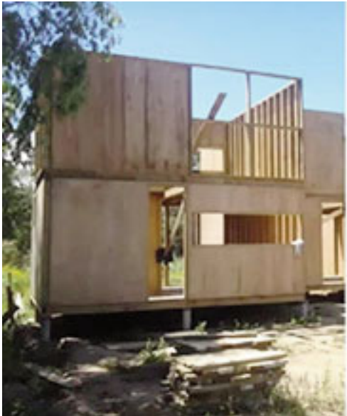
El sistema de construcción dominante es el de plataforma. Todos los muros son portantes.
