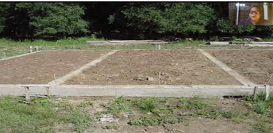
Sistema de pilotines y vigas por sobre el terreno
