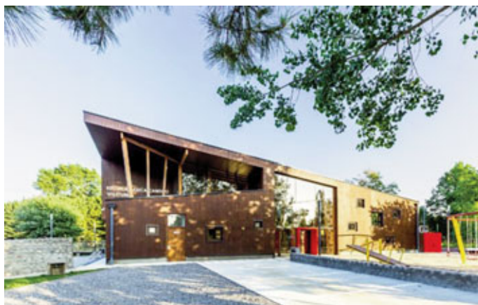
En Escuela Rural Básica Cantino la tipología estructural predominante se ejecutó con madera de pino radiata y elementos principales de madera laminada.
