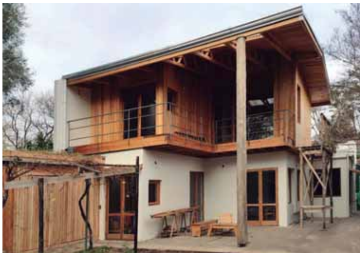
Vista de la obra terminada.
