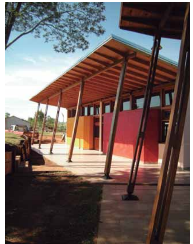
"La Escuela N°892 es una obra de carácter social, en donde se deben trabajar con recursos propios del lugar, tanto en materiales como en mano de obra. Se utilizó madera certificada porque es muy fácil de conseguir en Misiones", señaló el arquitecto Pablo Lavaselli en exclusiva.
