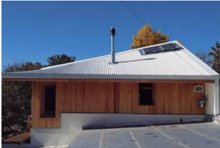
Imagen del techo una vez terminado.
