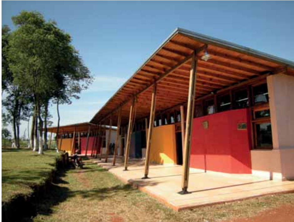
La escuela cuenta con tres aulas, servicios sanitarios, cocina, comedor-salón comunitario y galerías. Además, se logró instalar la red eléctrica y realizó la perforación para obtener agua potable para la comunidad.
