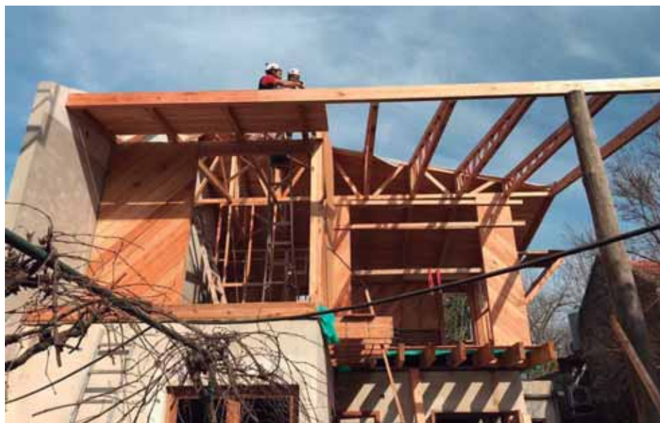
Estructura a la vista de la casa a medio hacer.
