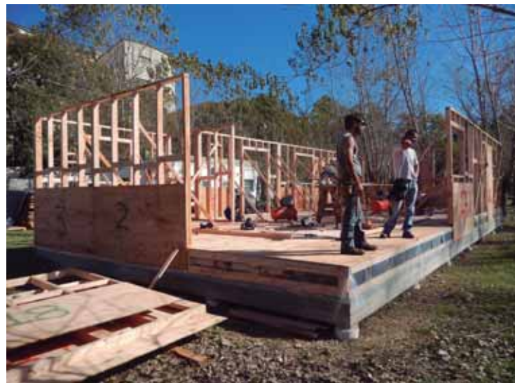
Avance de obra en La Plata, en 2015.
