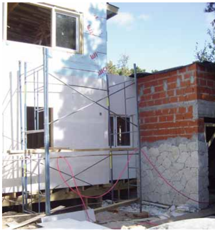
Armar y levantar la tabiquería exterior e interior y la estructura del techo insume unos 15 días.
