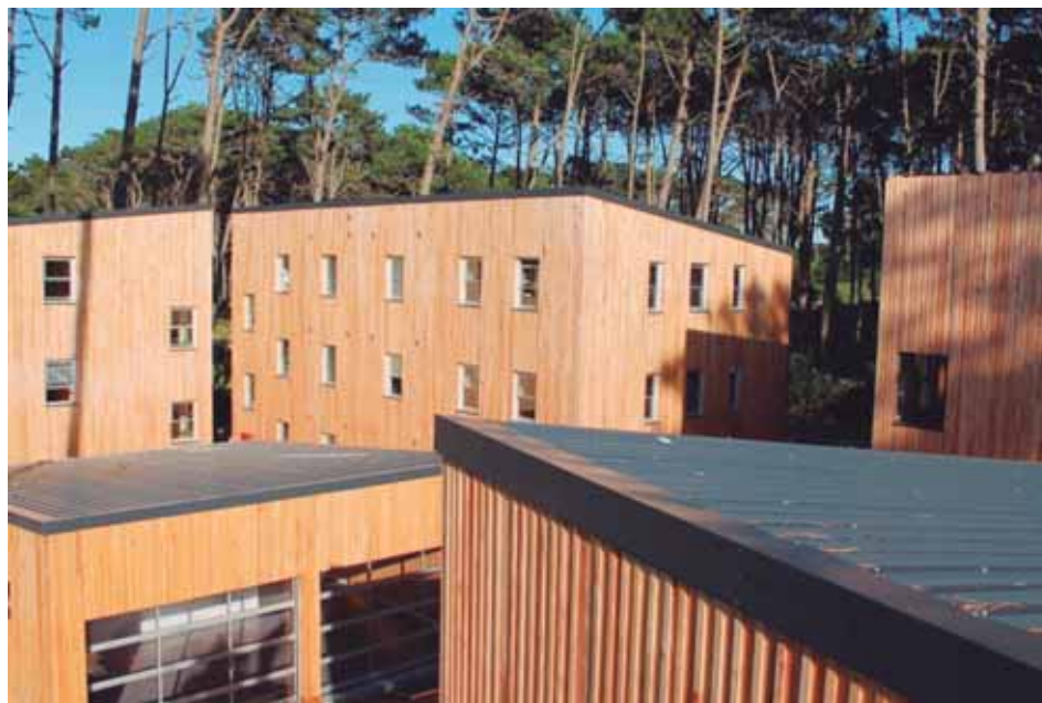
Posada Vik es un complejo de viviendas turísticas construido en paneles CLT
