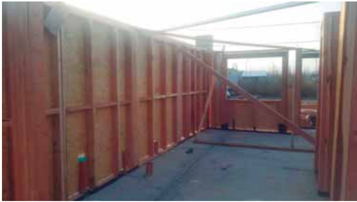
Las construcciones se montan sobre paneles de pino Oregón o lenga.
