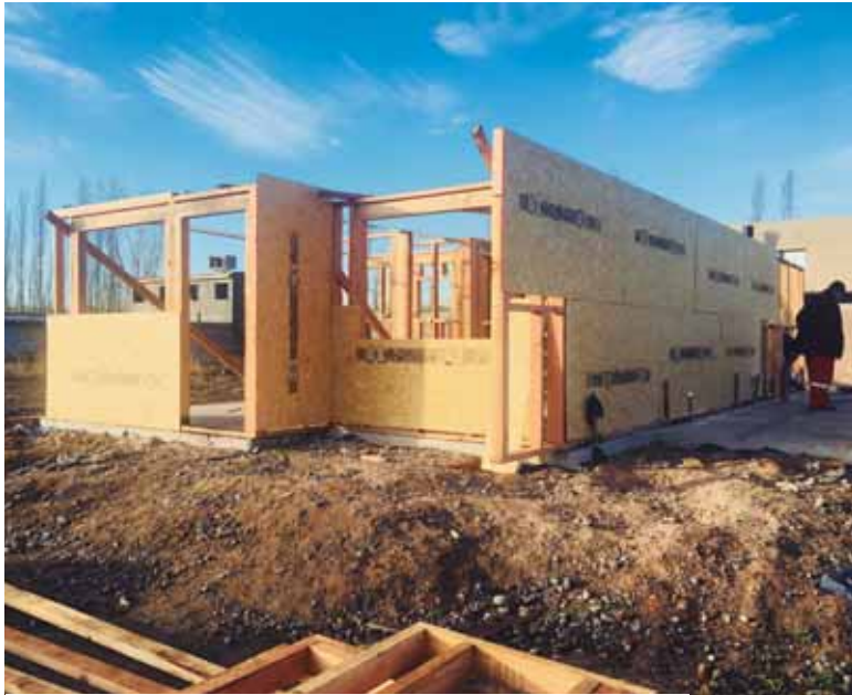
Las plateas de las viviendas se hacen la norma CIRSOC 201, que es una norma sísmo resistente para la Patagonia.
