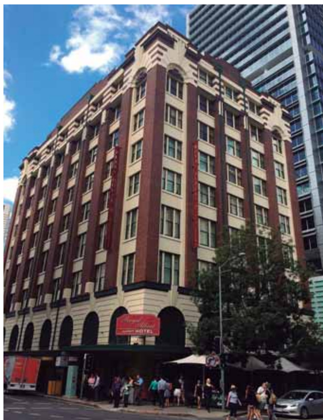
Perry House se terminó de construir en Brisbane, Australia, en 1913. También cuenta con fachada de ladrillos y estructura de vigas y pilares de madera.
