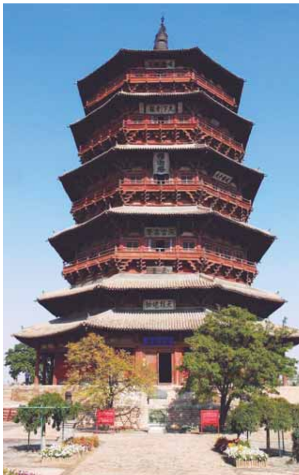
Pagoda Yingxian, en China, se construyó en 1056 usando exclusivamente madera y sin usar un solo clavo ni tornillo. Mide 65 metros de altura y es aún hoy el edificio de madera más alto del mundo.
