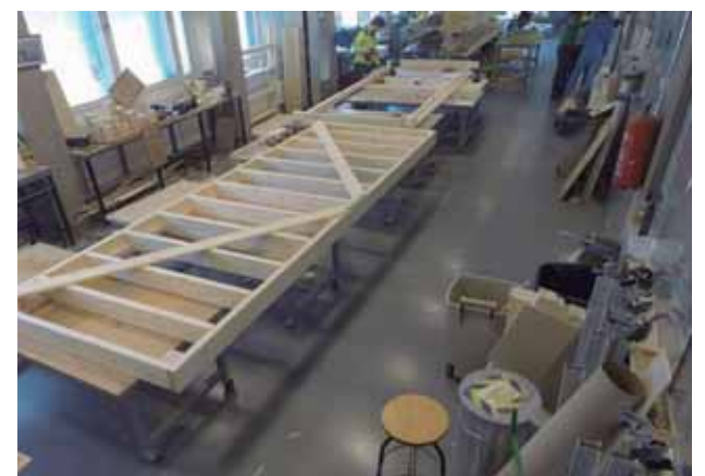
a)Prearmado de paneles en madera en fábrica, lo que acelera los tiempos constructivos del sistema.
