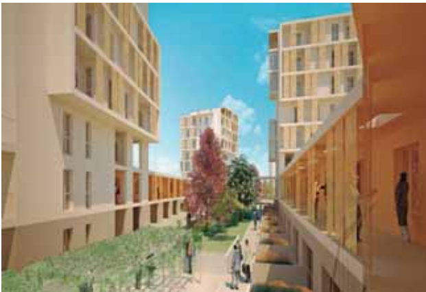
Complejo Cenni di Cambiamento en Milán, Italia, de nueve plantas. Planta baja, sistema estructural, núcleo de ascensores y forjados están hechos en paneles CLT.
