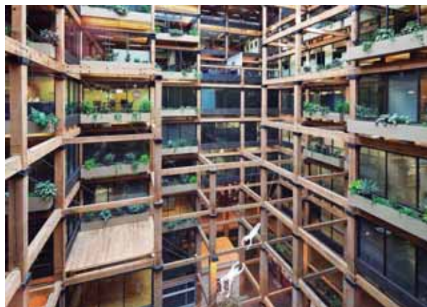
Butler Square se construyó en 1906 en Minneapolis, Estados Unidos. Fue de tipo de edificio con fachada de ladrillos y estructura de esqueleto (vigas y pilares) de madera.
