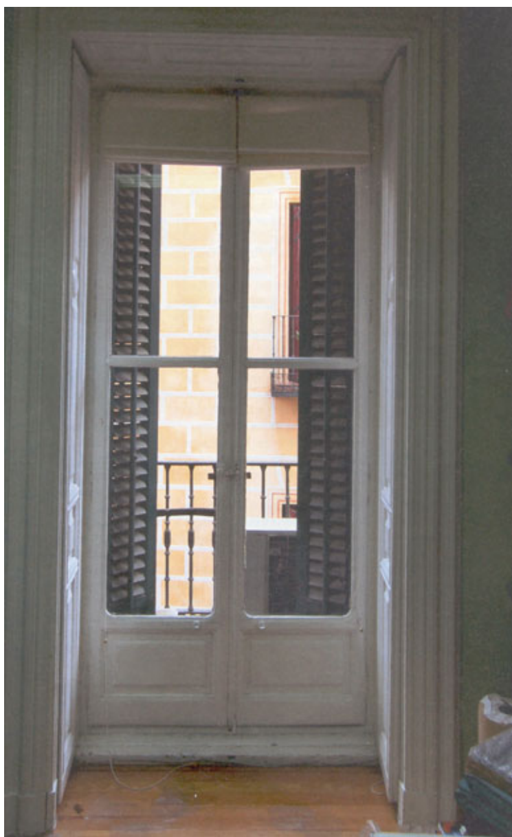
Unidad completa de puerta-ventana, o balconera de finales del siglo XIX. Incluye: contraventanas con persiana, mallorquina articulada, hojas abatibles con cierre de españoleta y fraileros escamoteables en caja. Marco rematado con plinto en el encuentro con el rodapié.
