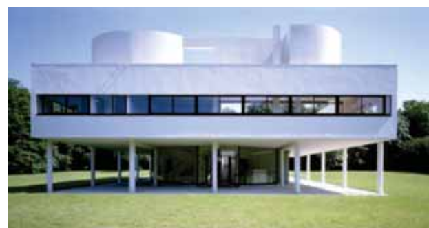
Le Corbusier estaba obsesionado con la epidemia de tuberculosis. Tanto es así, que en su propia casa -Villa Savoy- instaló un lavamanos al lado de la puerta principal.
