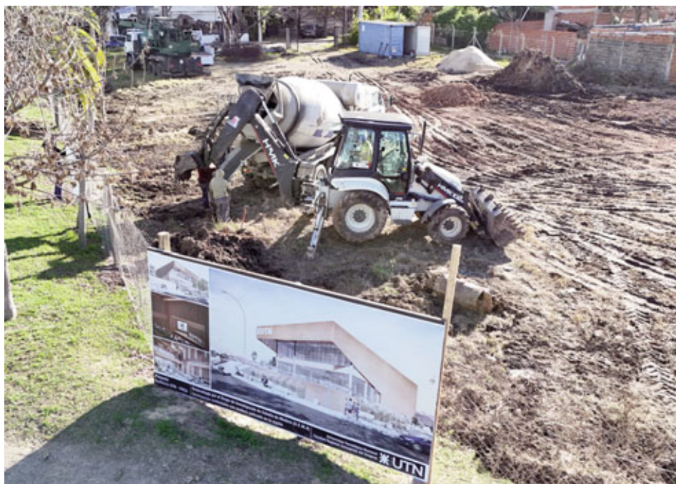
Se ha finalizado el pilotaje. En lo que resta del año comenzará la obra de hormigón armado -losa inferior, columnas y losa superior- para cocheras, que se prevé terminar para febrero de 2027.
