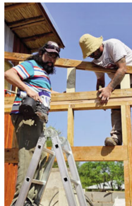
Wood Frame plantea una metodología constructiva que requiere precisión, planificación y conocimiento de cada una de las etapas que intervienen en la ejecución.
