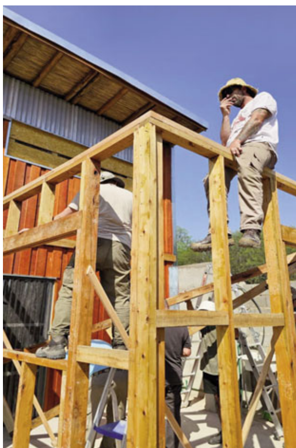
Los participantes pudieron aprender midiendo, replanteando, cortando, armando y montando los distintos componentes de una estructura de madera.
