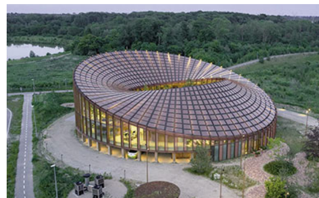
El edificio de 2.800 metros cuadrados combina arquitectura en madera, eficiencia energética y diseño biofílico.
