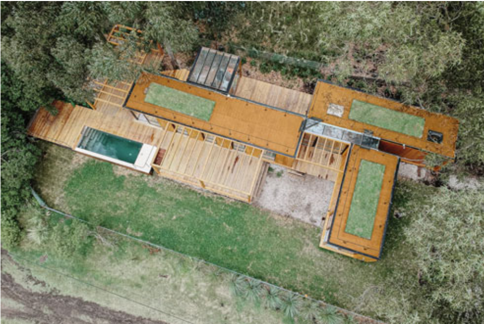
Vista de la casa desde un dron.
