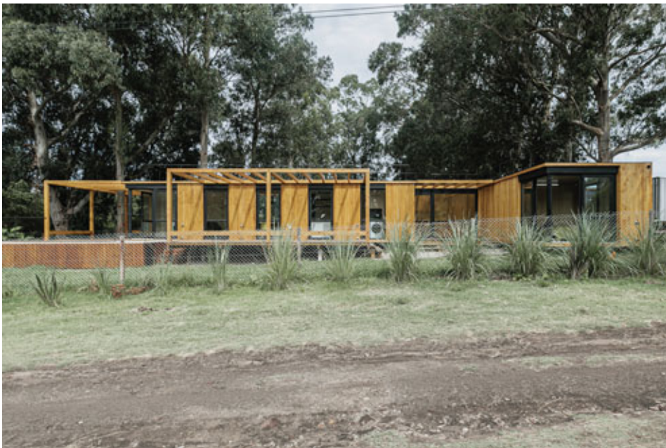
La casa está sobre bases que se instalan en pocas horas y que pueden ser removidas rápidamente.
