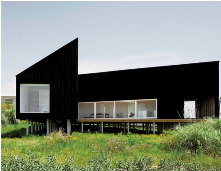
“La elección de madera proveniente de forestaciones locales como material básico de construcción responde a la voluntad de reducir costos y tiempos a través de la prefabricación modular, así como de utilizar materiales de origen sustentable”, le dijo el arquitecto Diego Arraigada a Todo Madera.
