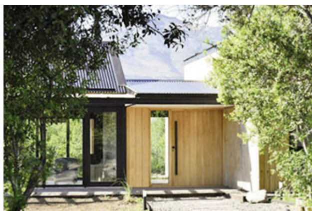
Casa MO, ubicada en San Martín de los Andes.
