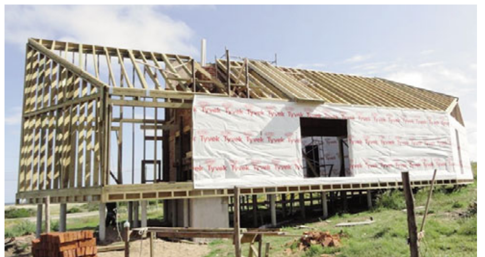
El bastidor, junto con las placas de rigidización, forman la estructura. Luego en los espacios entre parantes se coloca la capa de aislación térmica. Por fuera la capa hidrófuga.
