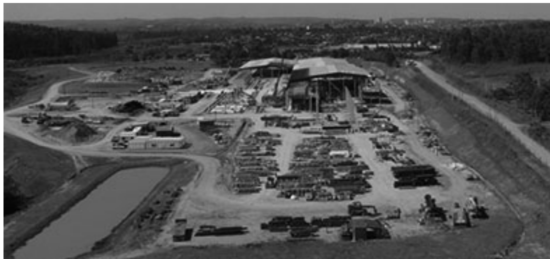
Construcción de la nueva planta de pino aserrado.
