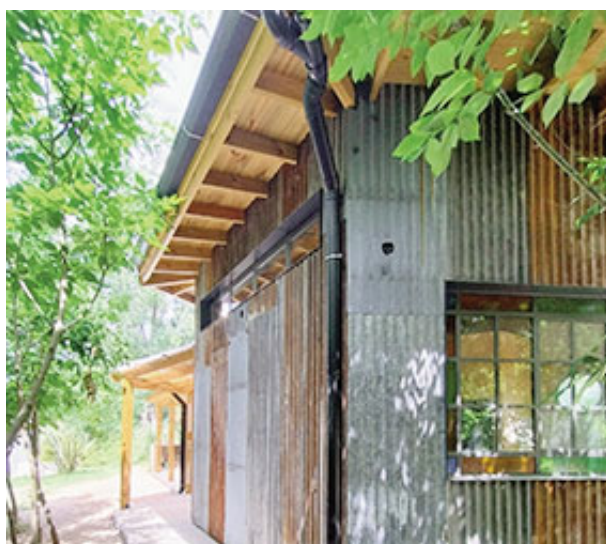
La estructura está resuelta en escuadrias 2 pulgadas por 4 pulgadas y los dinteles son de doble 2 pulgadas por 6 pulgadas.
