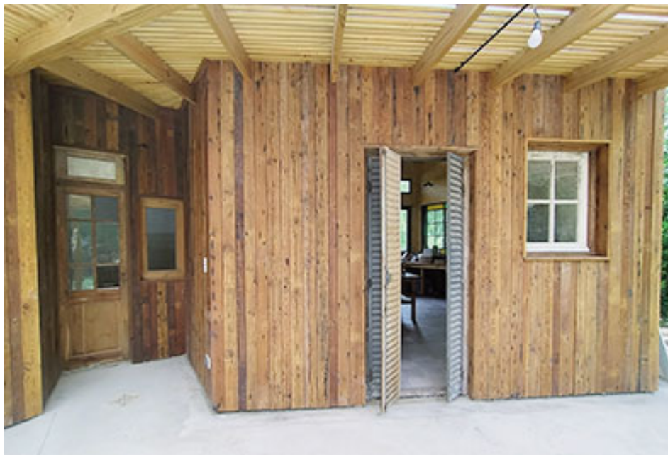
“Trabajamos con el sistema wood frame, priorizando precisión, eficiencia térmica y calidad de ejecución”, dijo el entrevistado.
