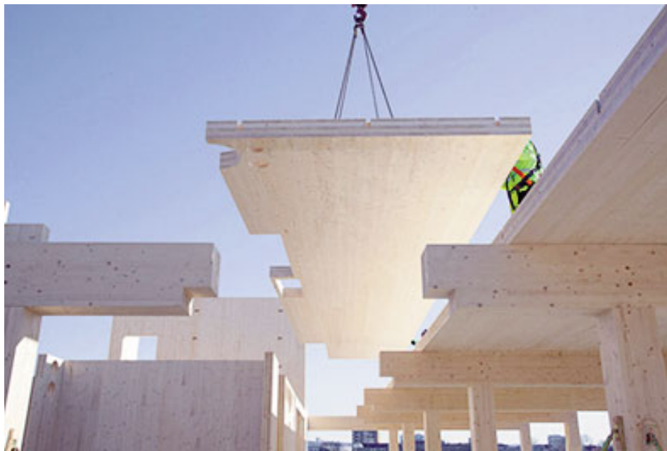
HasleTre: primer edificio de oficinas de madera del mundo diseñado para ser desmontado. OsloTre arquitectos.
