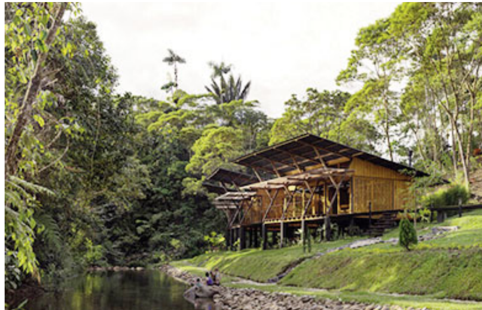
Troncos de ejemplares de Killis existentes en el lote, son tomados y llevados al taller de carpintería, son tratados y regresados nuevamente a su lugar.
