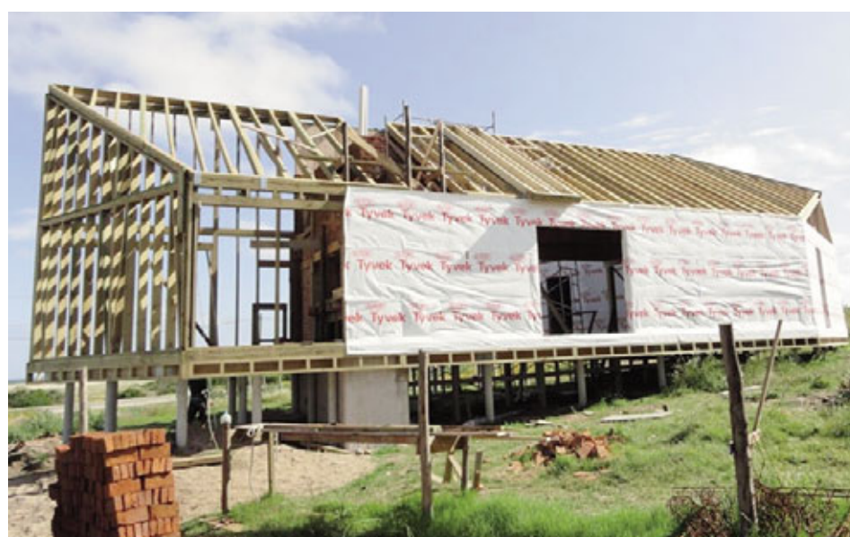
El bastidor, junto con las placas de rigidización, forman la estructura. Luego en los espacios entre parantes se coloca la capa de aislación térmica. Por fuera la capa hidrófuga.
