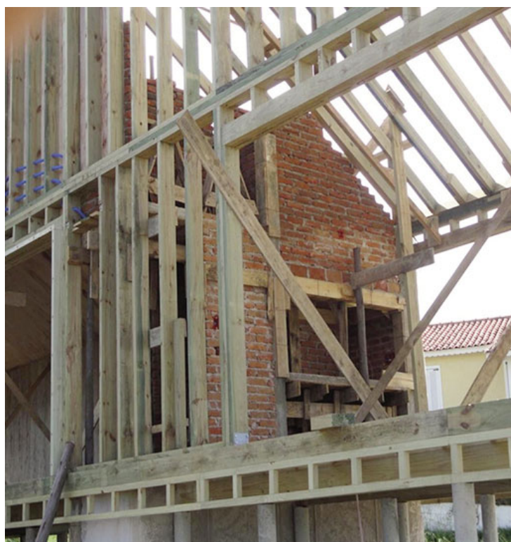
Cerrando el sistema de bastidores y como elemento de rigidización (sheathing) se emplearon placas de multilaminado fenólico.
