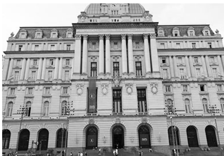
Fachada actual del rebautizado Palacio Libertad.
