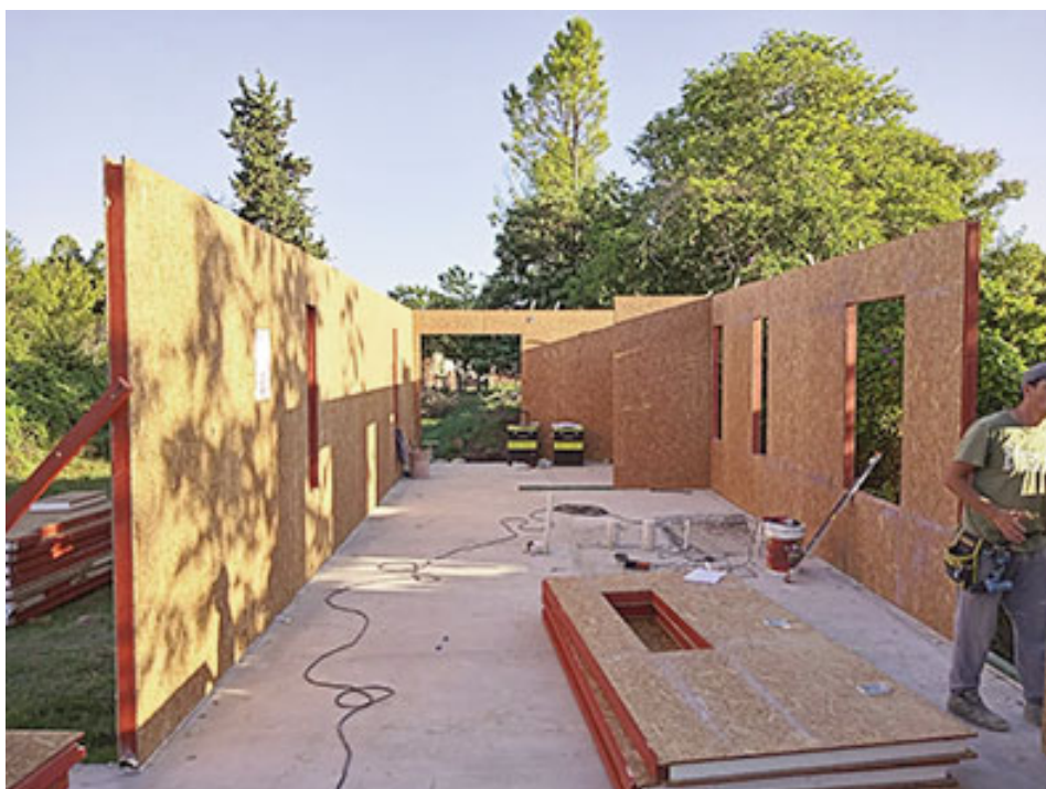
Un constructor solo trabaja en el montaje de la obra.
