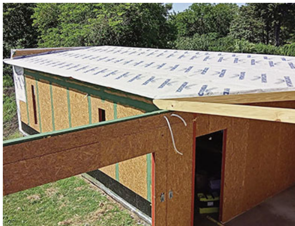
Colocación de aislante.
