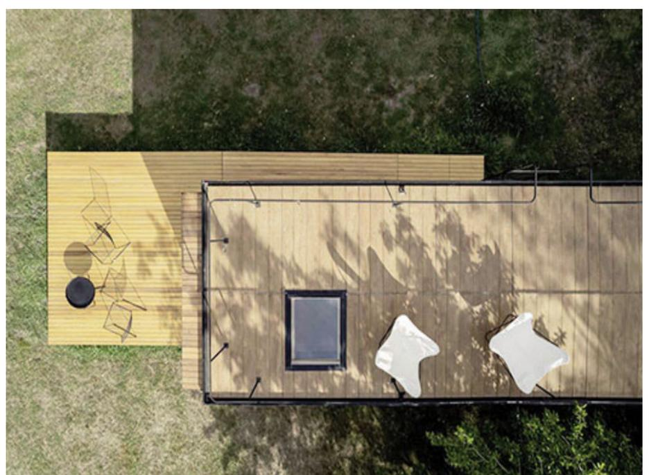
En verano con la apertura de las lucernas de la cubierta se logra que el aire caliente alojado en el interior sea impulsado hacia el exterior.
