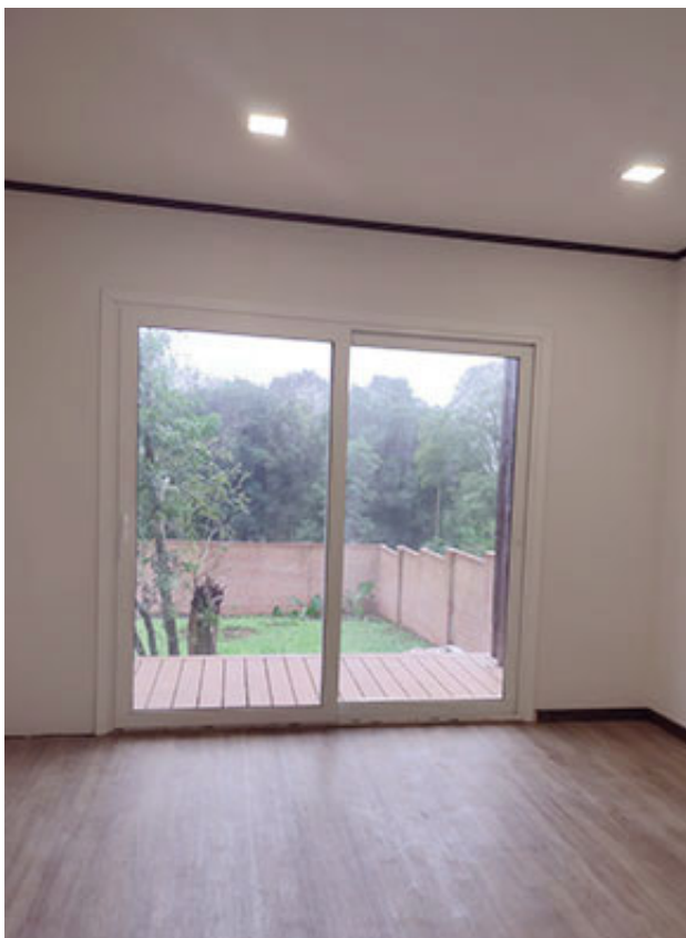
Los pisos son de madera de pino impregnada y cepillada.
