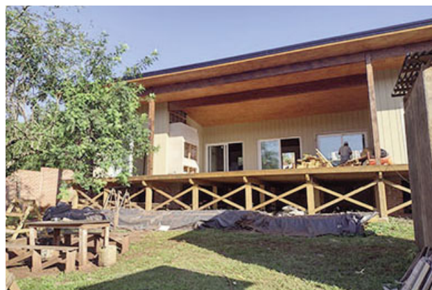
Vista del avance de obra de vivienda "llave en mano" que Rudolph construye en Eldorado, Misiones.
