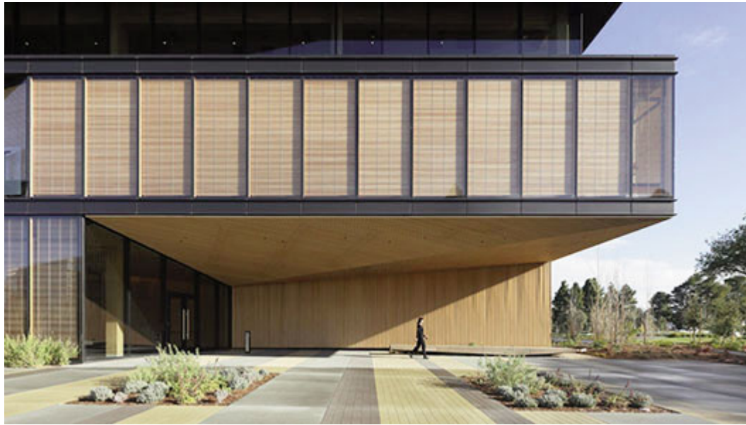
El sistema incluye persianas de madera situadas en una cavidad herméticamente cerrada, alimentada con aire seco para evitar la condensación.
