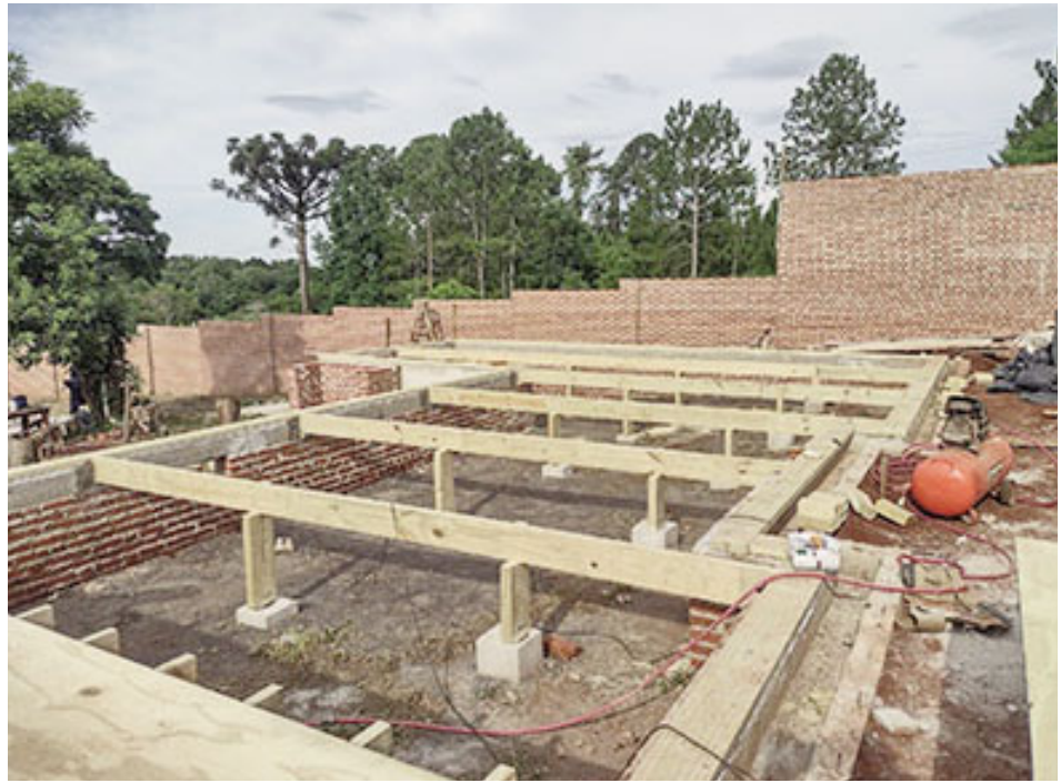
Montaje de las bases.
