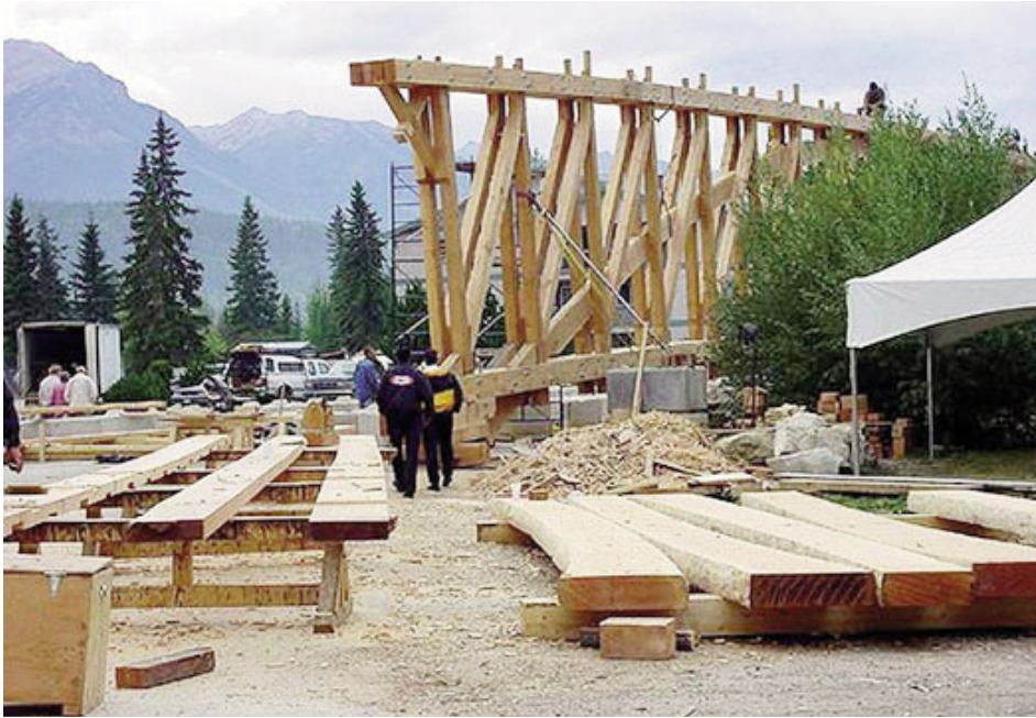
Las piezas son unidas sobre caballetes mediante pernos y pasadores de madera.
