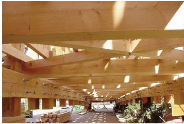
Las piezas son unidas sobre caballetes mediante pernos y pasadores de madera.
