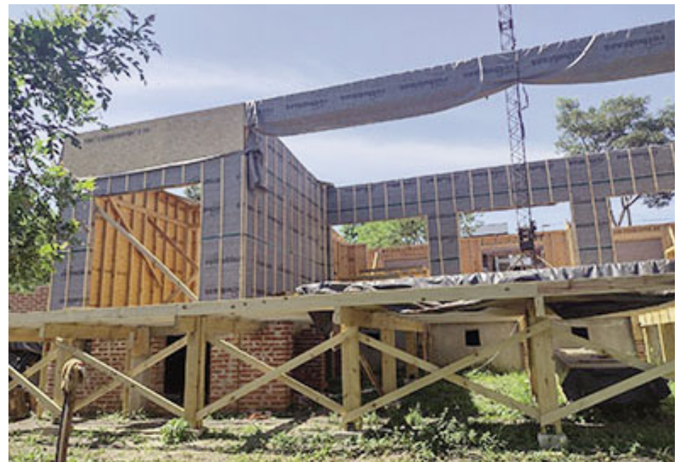
Colocación de aislantes.
