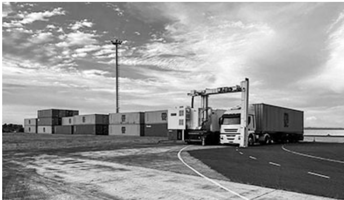
Escáner de camiones que se instaló en febrero pasado.
