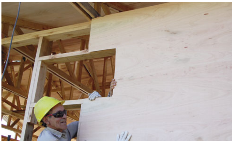
Los paneles que serán las futuras paredes se pueden transportar por dos personas.
