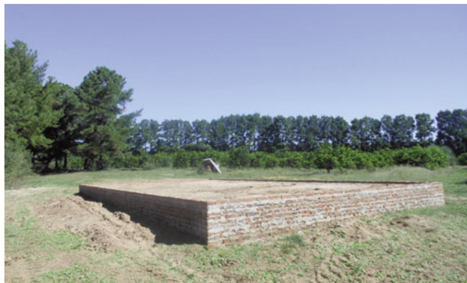
La zapata es un cuadrado con muros relleno de arena sucia.
