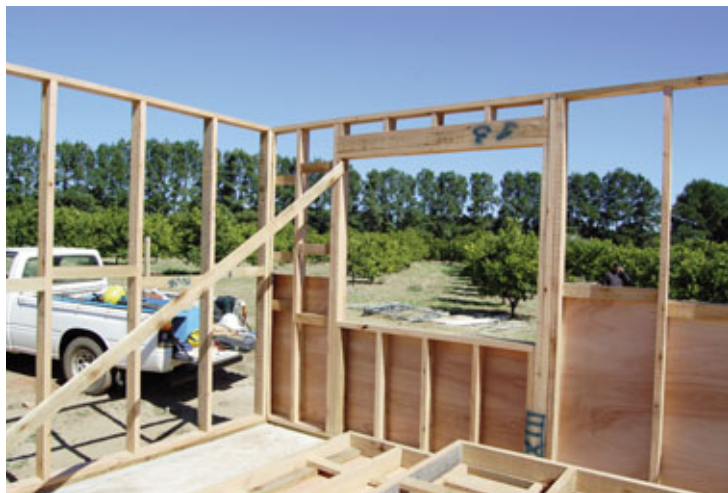
Los montantes por normativa deben tener 40 milímetros por 90 milímetros y son cepillados.
