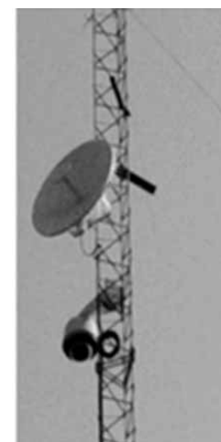
A la izquierda, torre de detección con observador en cabina. A la derecha, mástil con cámara tipo domo y antena de transmisión y recepción.
