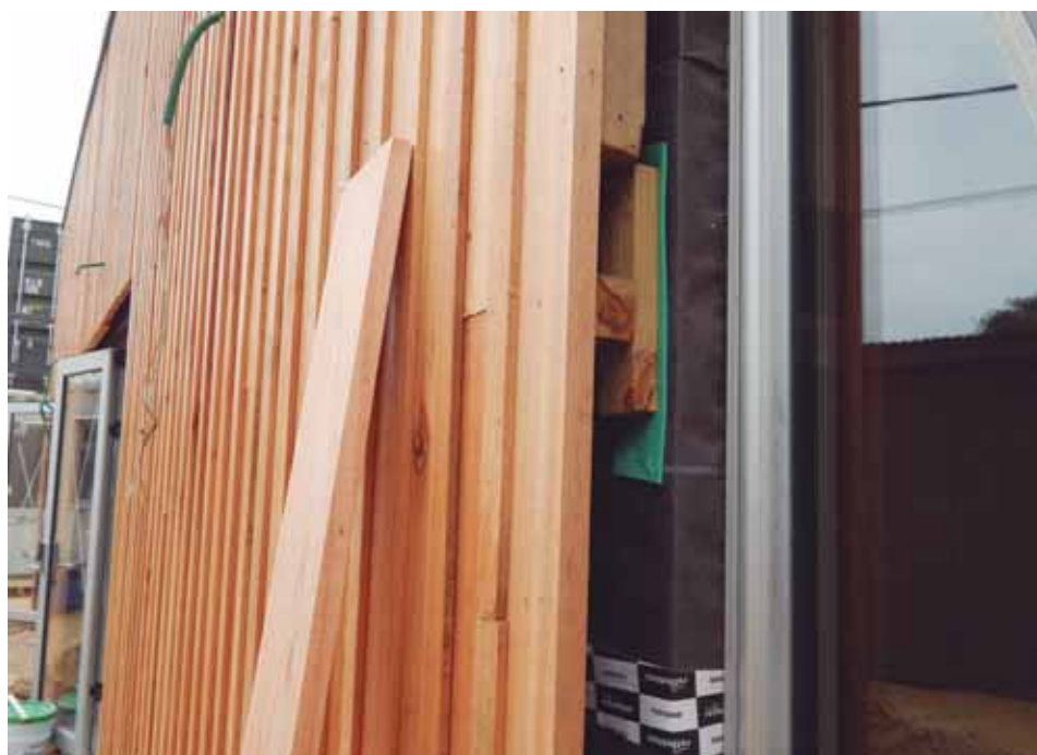
Los paneles CLT son de madera de abeto de tres capas de 1,5 pulgadas cada una, con cobertura externa de eucaliptus grandis local.
