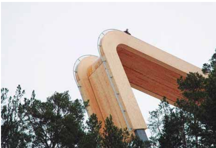
El mirador-puente tiene 30 metros de alto, como un edificio de 10 pisos.
