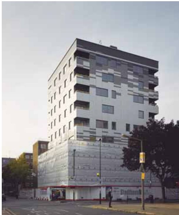
La estructura de 30 metros de altura y ciento por ciento reciclable, es un buen ejemplo de las posibilidades que ofrece la madera para el diseño y la construcción.
