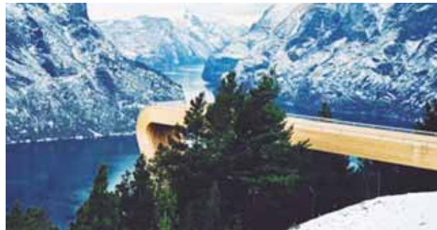
La construcción es una estructura en el aire de 4 metros de ancho
