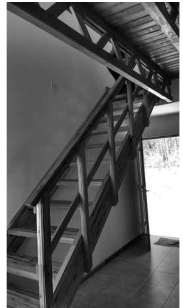
Escalera de la vivienda destinada al cuidador.
