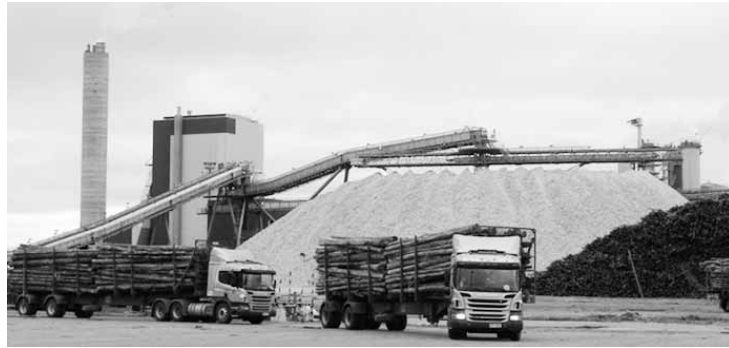
UPM invertirá US$ 4.000 millones en la nueva planta. En la imagen, playa de carga de la planta de Fray Bentos.
