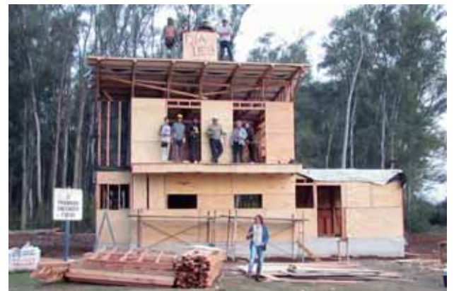
Avance de obra tras la tercera jornada. "Al tercer día estábamos montando el techo", afirmó el doctor en ingeniería Martín Sánchez Acosta, quien trabaja en INTA Concordia.
