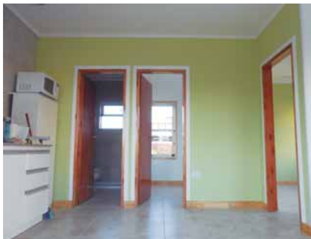
Las terminaciones interiores tienen buena prestación.
